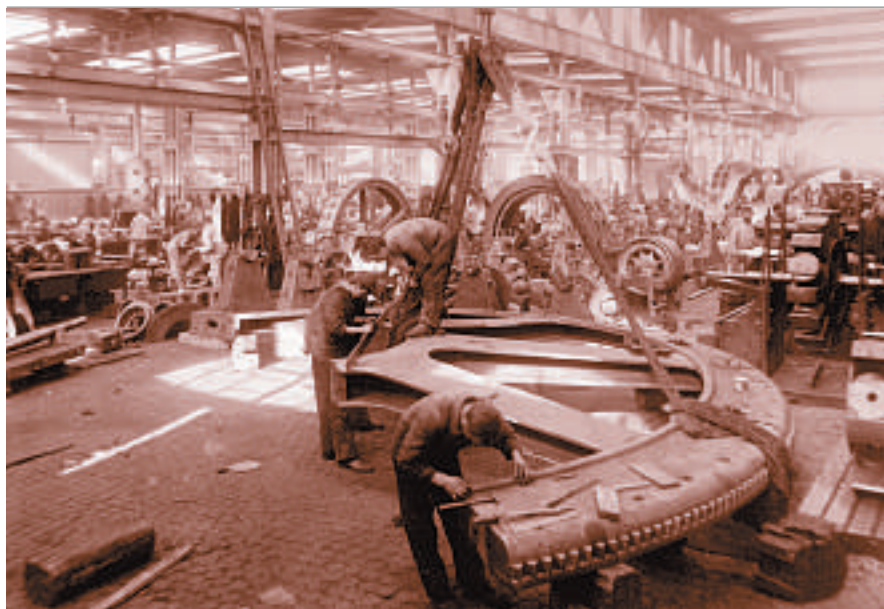
Montaje de un generador en Baden, Suiza (1985)
