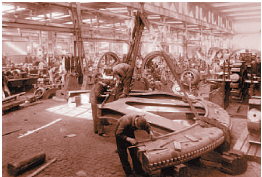
Montaje de un generador en Baden, Suiza (1985)
